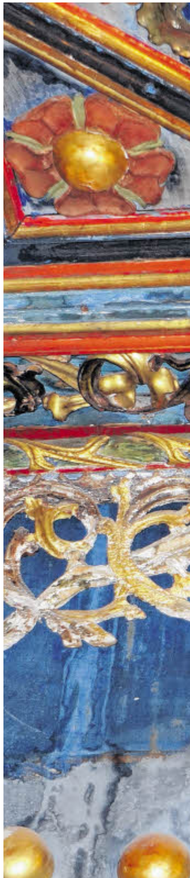
Wasserschäden, abblätterndes Gold, fahle Farben: Die Fürstenzimmer auf der Festung Hohensalzburg sind in traurigem Zustand.
